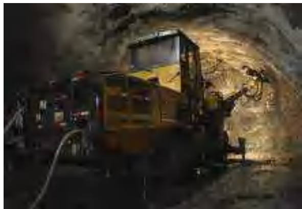
Túnel GGE - Portal Giraldo Frente de excavación
