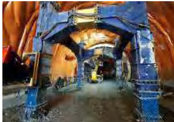
Túnel 15 - 16 Proceso de revestimiento
