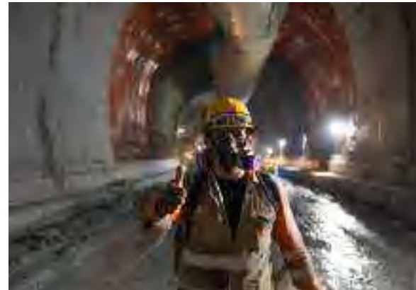
Túnel 15 - 16 Proceso de revestimiento
