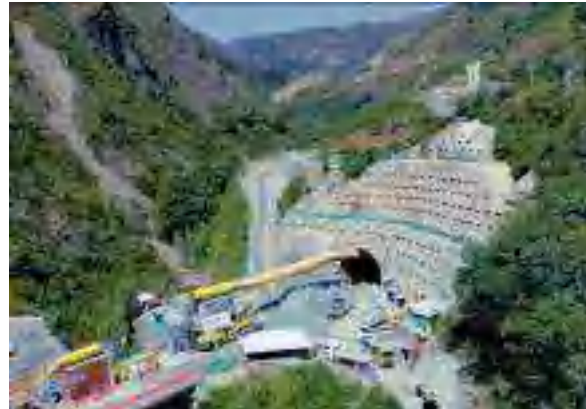
Túnel 17 Portal Giraldo
