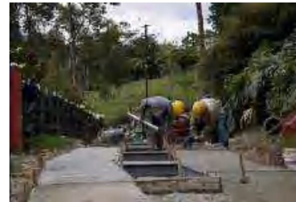
Vía El Cerro – El Rincón Venecia
