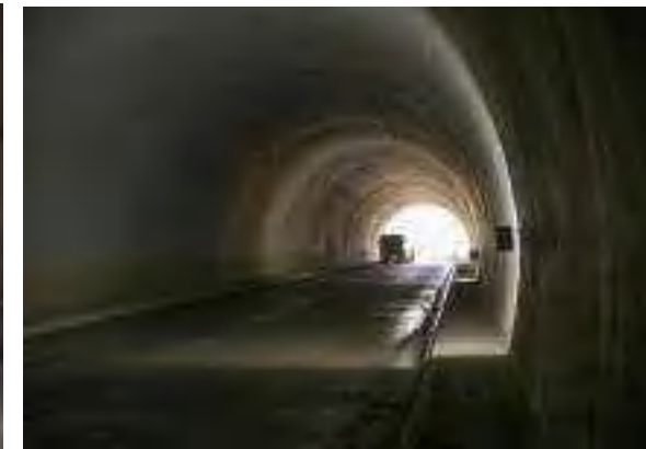
Túnel 18 Revestimiento completo
