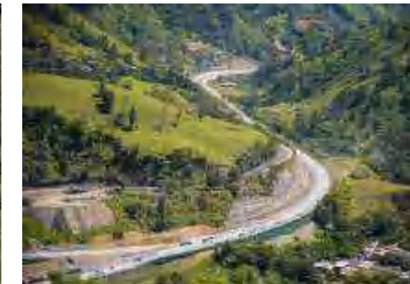
Frente 1 Vías de acceso
