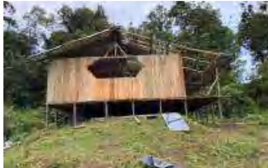
Inicio de construcción.
