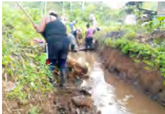
Inicio de construcción.
