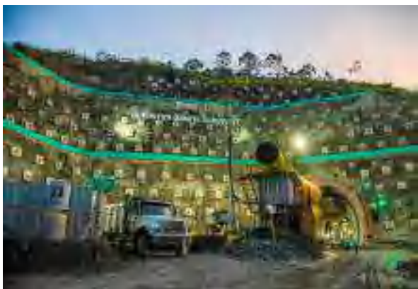
Túnel 17 Portal Cañasgordas
