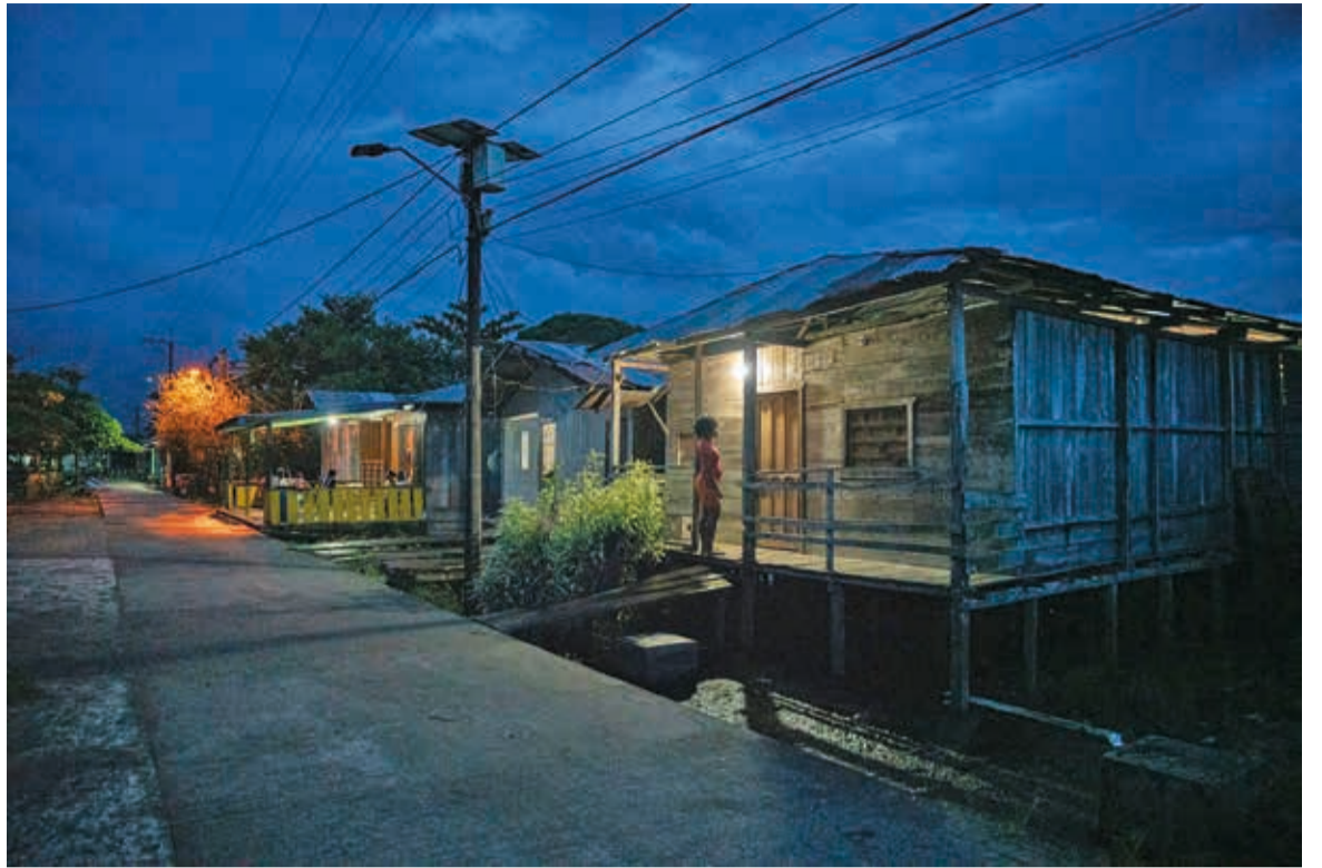
Electrificación en Vigía del Fuerte.
