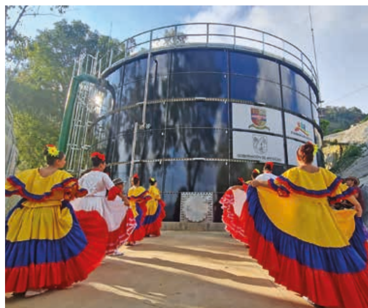
Nuevo tanque de almacenamiento de agua en Jericó.
