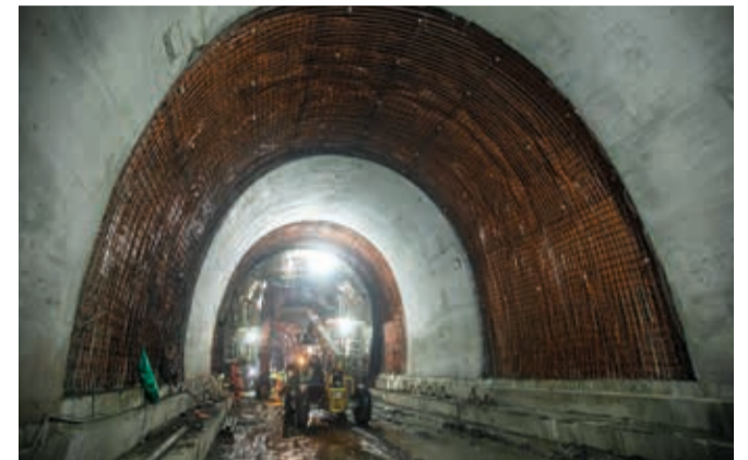
Proceso de impermeabilización y revestimiento en concreto hidráulico.
