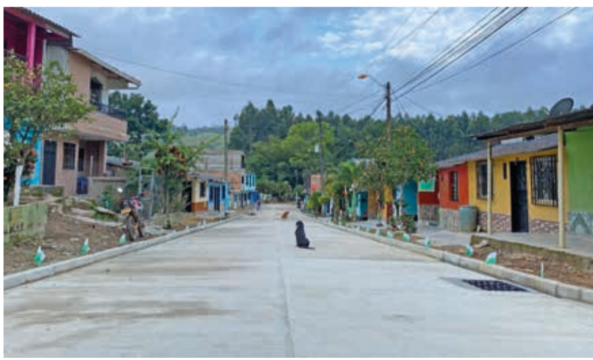
La pavimentación de vías urbanas mejora la calidad de vida de cientos de miles de habitantes del territorio. Municipio de Vegachí.
