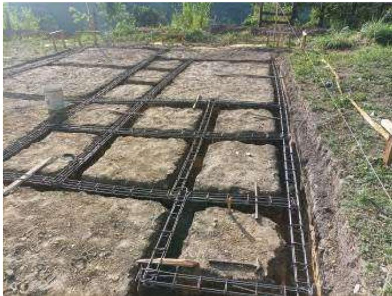
Descripción: Se aprecian las bases en acero de las viviendas como parte del proceso inicial de construcción.
