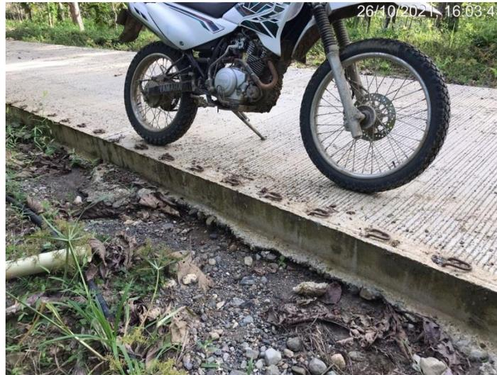
**Fotografía 2.** Erosión lateral de los bordillos
