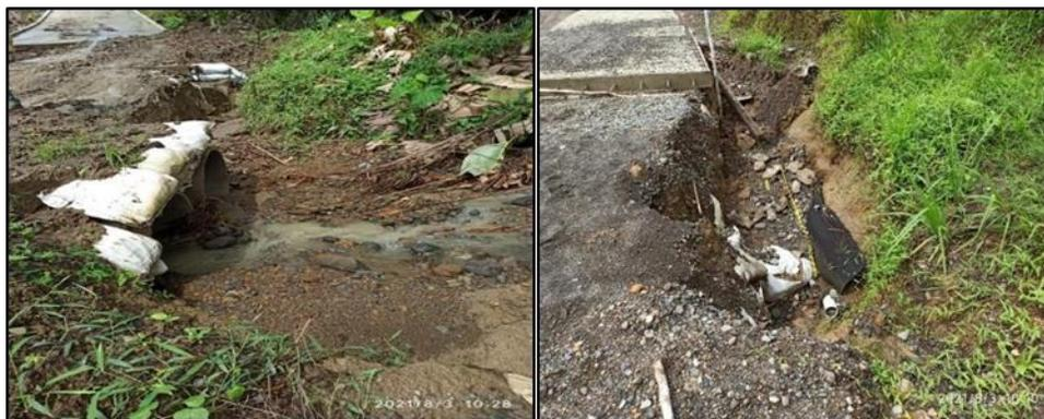
Fotografía 18 socavación por flujos de agua municipio de Turbo, Antioquia
