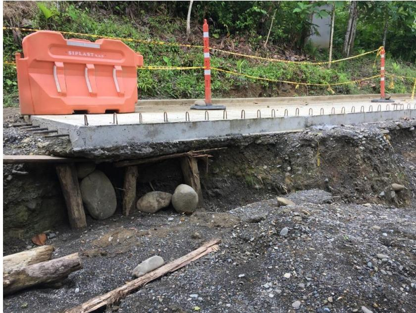
**Fotografía 1** Perdida de banca por movimiento de talud.
