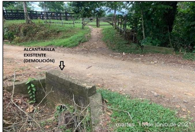
**Fotografía 10** Demoliciones de estructuras existentes (Alcantarillas) Remigio –Chigorodó
