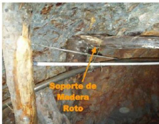
**Foto 5.** Interior de SP Sur. Soporte de madera roto debido a la humedad y presencia de hongos que terminaron por podrirlo. Macizo Rocoso sano, poco húmedo y de buena calidad. Soporte en madera que no está siendo solicitado por los esfuerzos del macizo rocoso.
