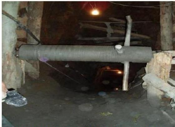
**Foto 4.** Interior de la mina en SP Norte. Puertas de madera separadas por varios metros y aisladas. Macizo sano, seco y de buena calidad, con soporte de puertas en algunos puntos.
