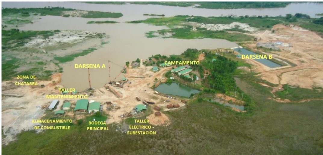
Figura 94. Vista aérea astillero.
