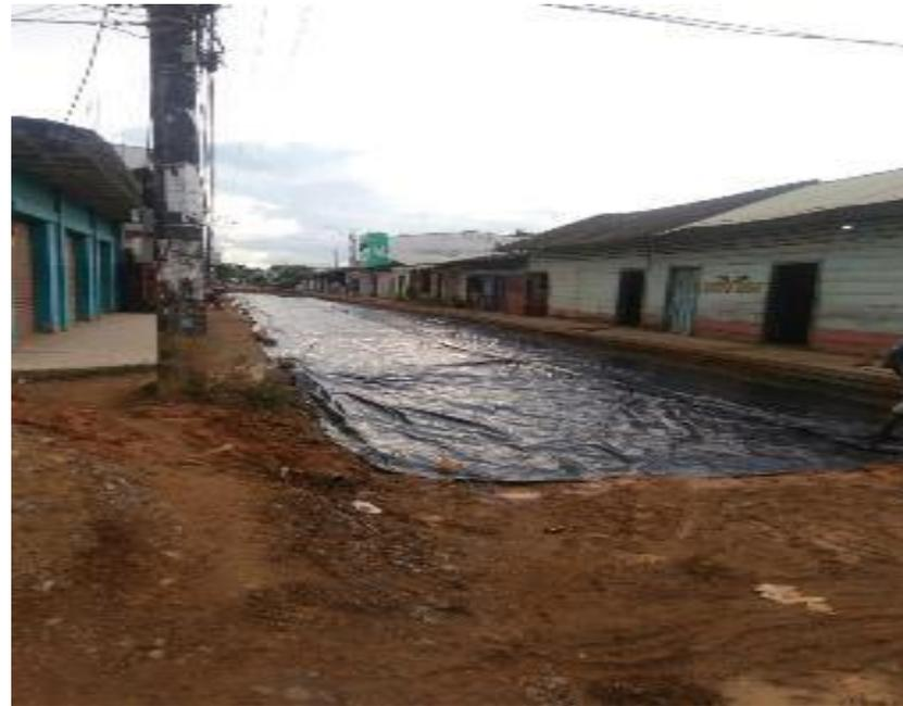
Protección de material de base para reposición de pavimento rígido.
